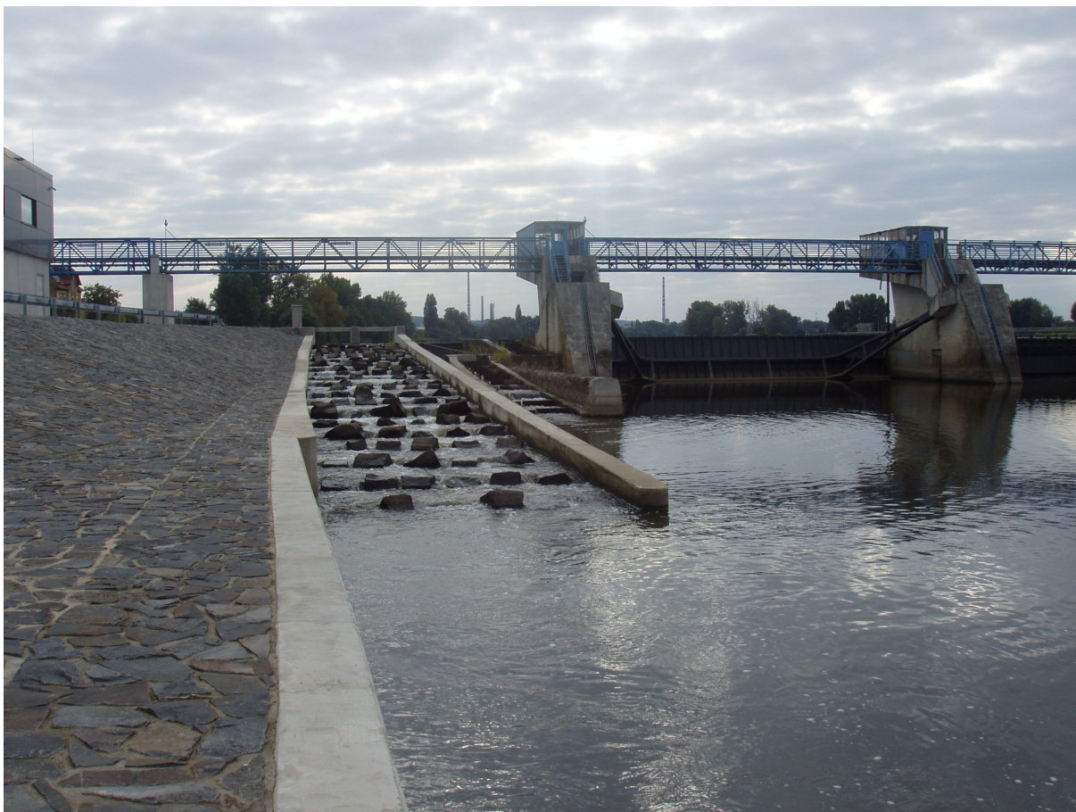
Obrázek 8 Vydařený rybí přechod typu rampa (Labe – Štětí). Foto K. Vrána.
