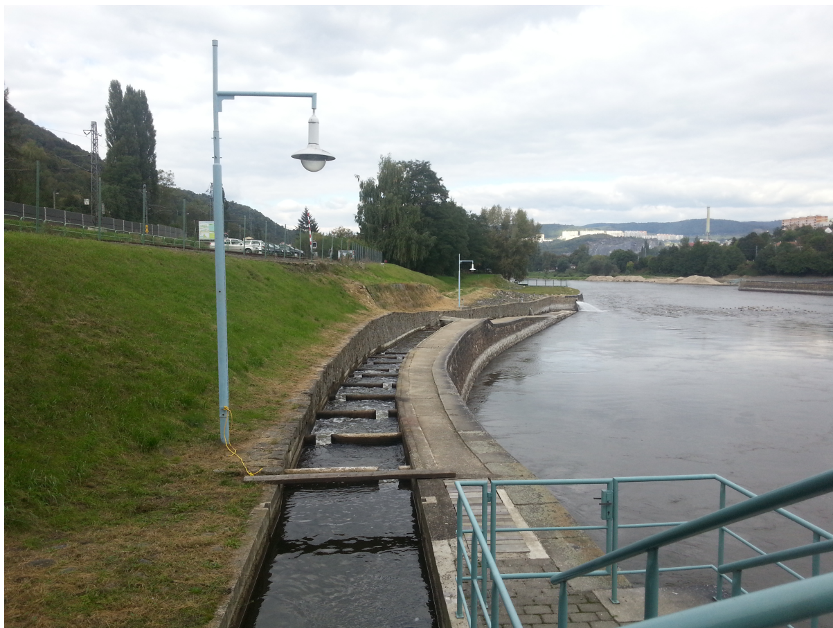
Obrázek 4. Technický levobřežní rybí přechod na VD Střekov - vstupní brána na území České republiky. Přechod byl VÚV T.G.M., v.v.i monitorován již v roce 2003. Současný monitoring pokročilými metodami sledování (RFID, kamerový bioskener) je realizován především v souvislosti se standardizací biologického monitoringu a jako důležitý podklad pro plánovanou přestavbu.
