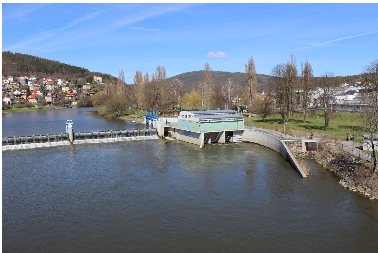
Obrázek 12 Jedna ze studovaných lokalit - MVE Beroun. Obrázek zachycuje 3 možné migrační cesty úhoře - jezové pole, MVE (s bezpečnostními prvky na ochranu ryb během poproudové migrace - elektrická zábrana na nátoku do MVE) a levobřežní přírodě blízký rybí přechod.
