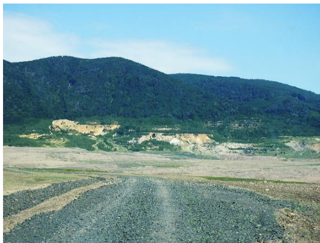
Navázání cestní sítě na již provedené stavby, příkopy není nutno zpevňovat betonem či dlaždicemi (Foto: M. Hendrychová)
