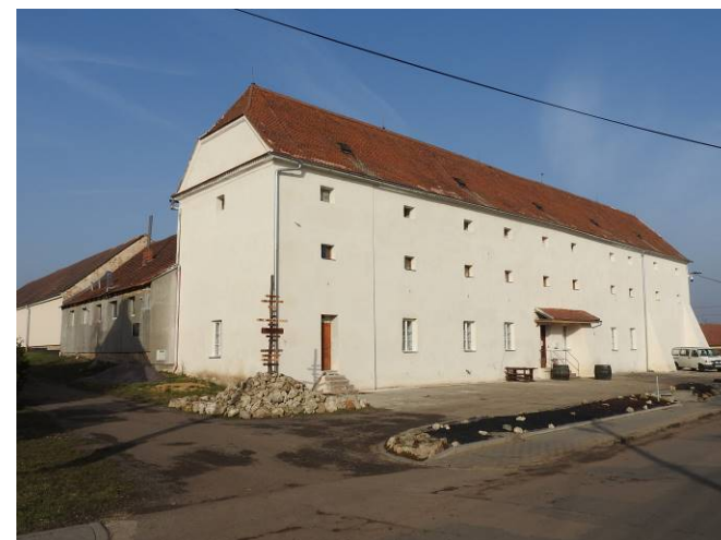
obr. č. C.123: Barokní sýpka, pozůstatek panského dvora; po obnově byly zachovány všechny charakteristické prvky – polovalbová střecha, pravidelné uspořádání malých okenních otvorů, nečleněná fasáda; Dominantní objekt při silnici do Bulhar.
