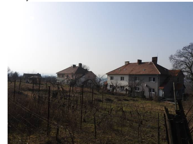
obr. č. C.90: Při renovaci objektu na protáhlé půdorysu byla zachována podlažnost, umístění vůči cestě i konstrukční tvar střechy.
