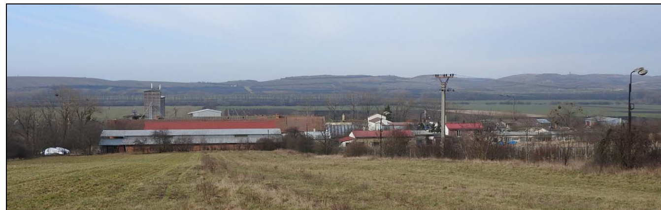
obr. č. C.15: Výrobní areál nad hlavní silnicí v pohledu od obce (od východu).
