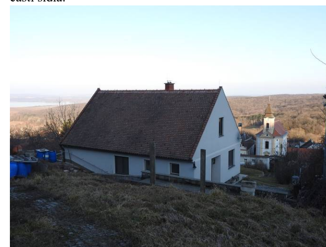
obr. č. C.66: Novostavba domu v severní části sídla působí ve venkovské zástavbě značně disharmonicky.
