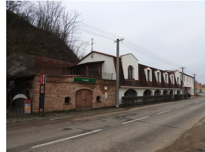
obr. č. C.37: Izolovaný komerční objekt na východním okraji sídla nevhodné architektonické formy.
