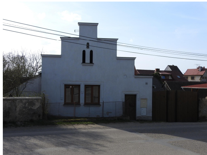
obr. . C.23: V zástavbě se výrazně vyjímá ojedinělý štuplový štít; tato forma se uplatňuje zejména v gotice, její reminiscence jsou patrné i v užití úzkých sdrůžených okének s obloukovým horním zakončením a nikou v podkroví
