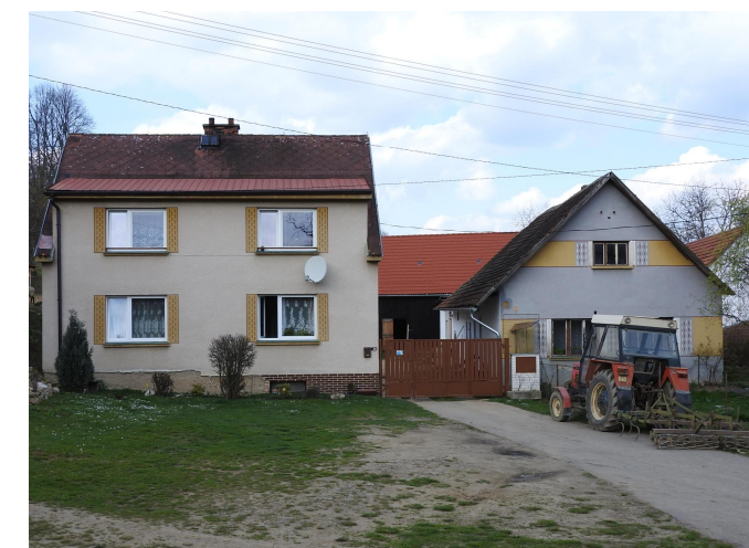
obr. . C.12: Jeden z mnoha p íklad nevhodných p estaveb vesnických staveb ze 70. - 80. let minulého století (podkrovní nástavba do sedlové st echy, -íroká okna zd razn ná postranními obklady a barevnými pásy na brizolitové fasád )
