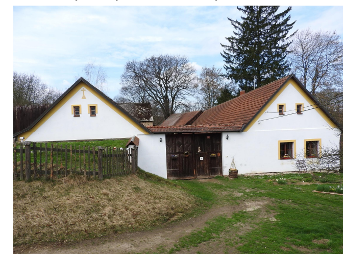
obr. . C.81: Prost ední usedlost jednoduchého uspo ádání; zda ílého výrazu bylo dosařeno i díky kvalitní obnov
