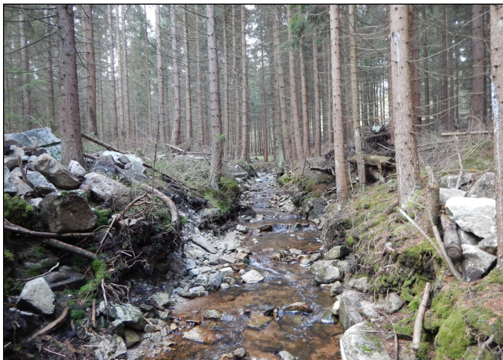
Obr. 9. Zhloubené upravené koryto Voložného potoka snižuje dobu koncentrace T_c v povodí, tj. urychluje odtok.
