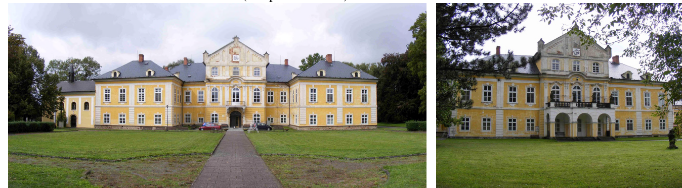
obr. C.93 a C.94: Zámek v Nové Horce (vstupní část vlevo)
