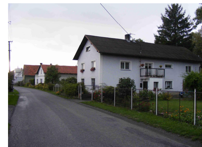
obr. C.59: Rekonstruovaný příčný orientovaný patrový dom sudetského typu se sedlovou střechou menšího sklonu
